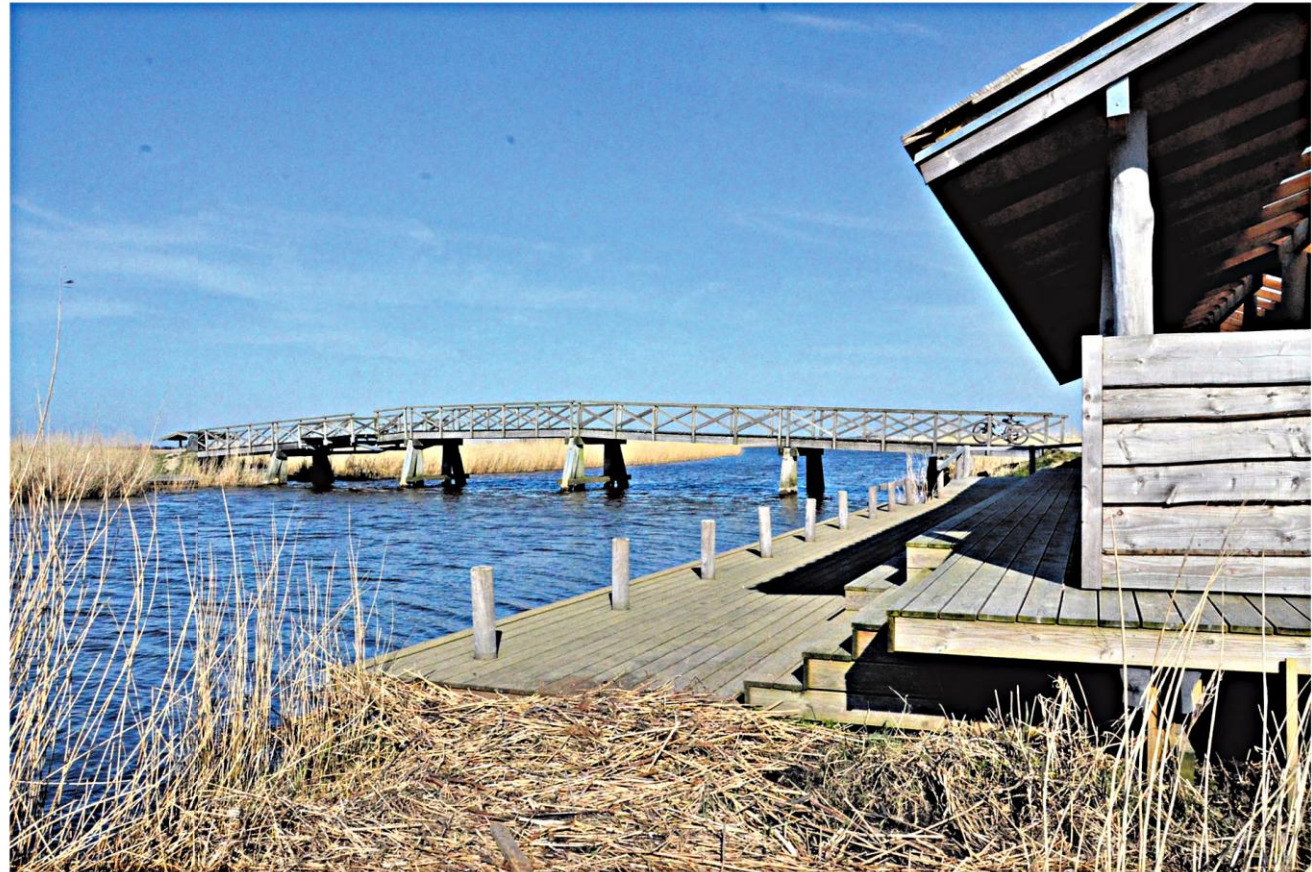
Flot ser det ud ved Hee Engbro. Her Vona og broen set fra madpakkehuset. Fotos Paul Osmundsen.
