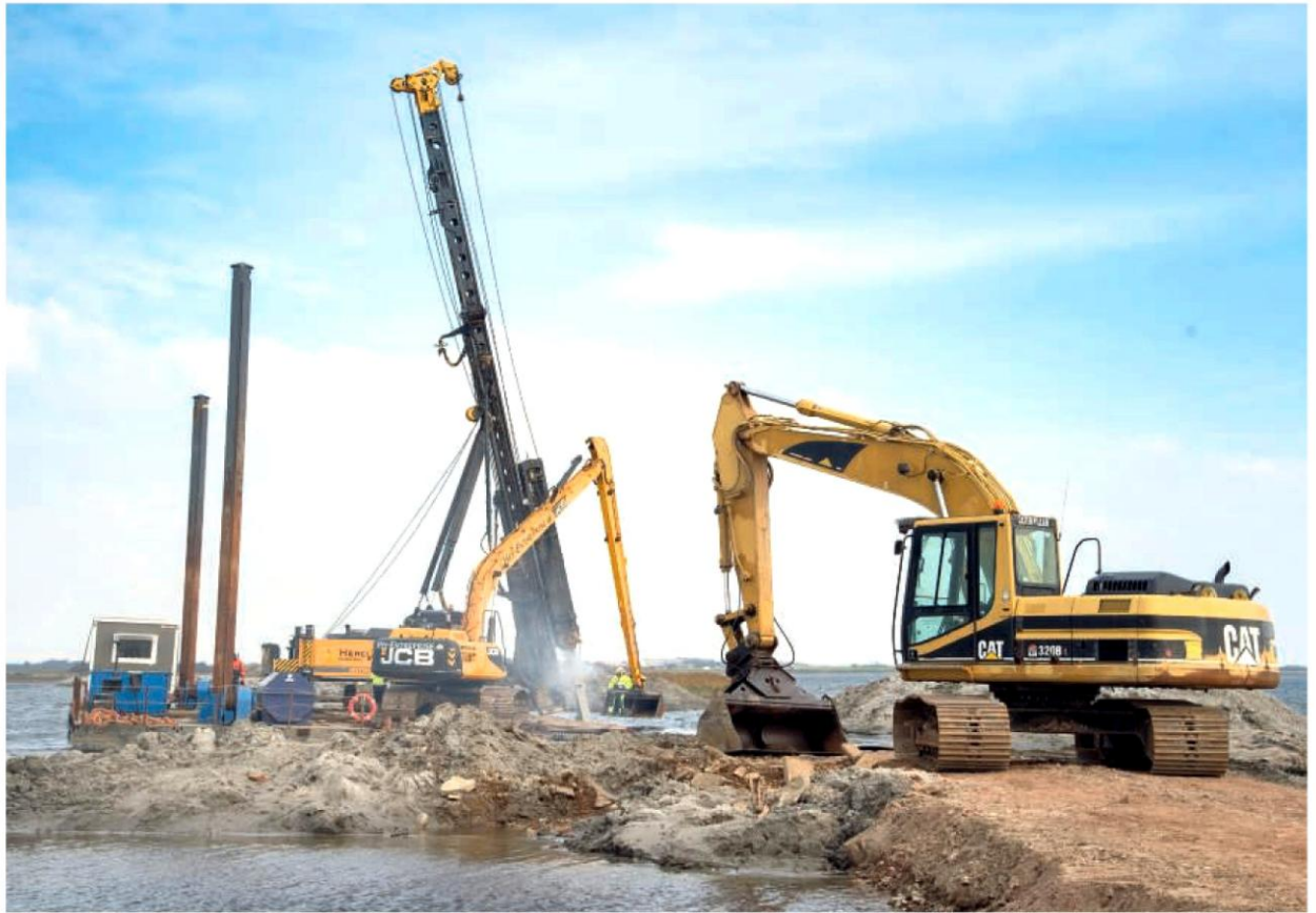
Betonpælene skal bære de færdigstøbte broelementer. Foto Tommy Kofoed
