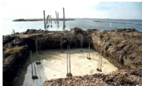
B. & V. Kristensen er i fuld gang med at støbe brofæstet på Ringkøbingsiden.
