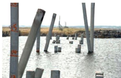
Nogle af pælene slås skævt i for at forhindre, at de trækkes op af den bløde bund.
